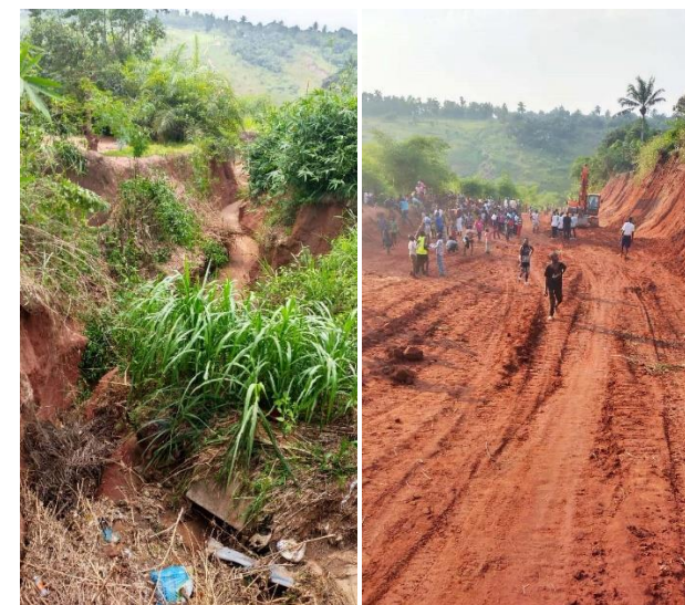
Réhabilitation de la route de desserte agricole R20. Avant (à gauche) et après (à droite) l'intervention d'engins et Equipes de HPEK
